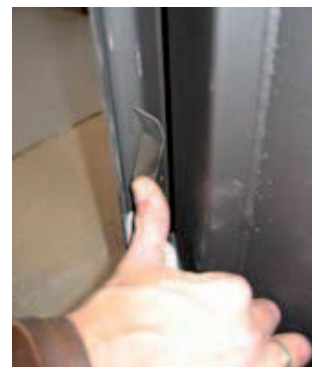
9. Montieren der Federklammern (6 Stck.) für die Seitenkacheln.
