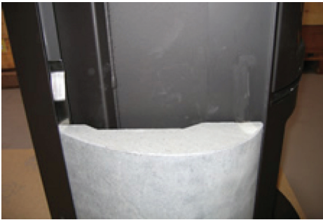
10. Anbringen der Klammern bei der unteren Kachel, bereit für die nächste.
