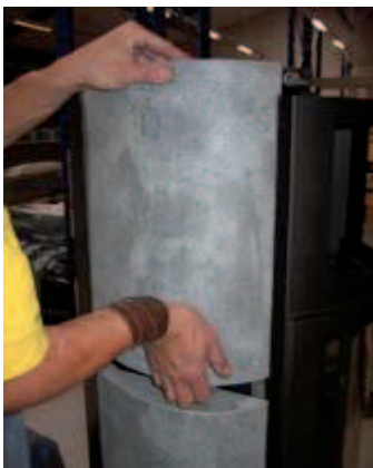
12. Montieren der oberen Seitenkachel.
