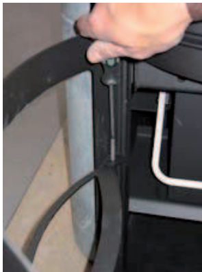
36. Die beiden Pinolschrauben in der Tür für den Aschenkasten montieren.
