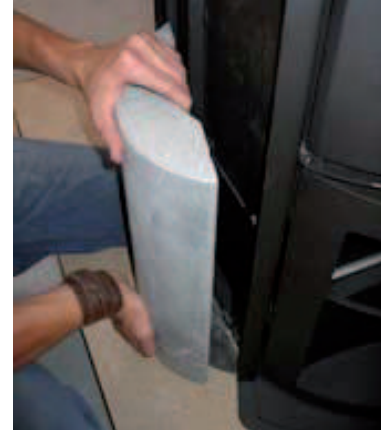
7. Die Seitenkacheln montieren.
