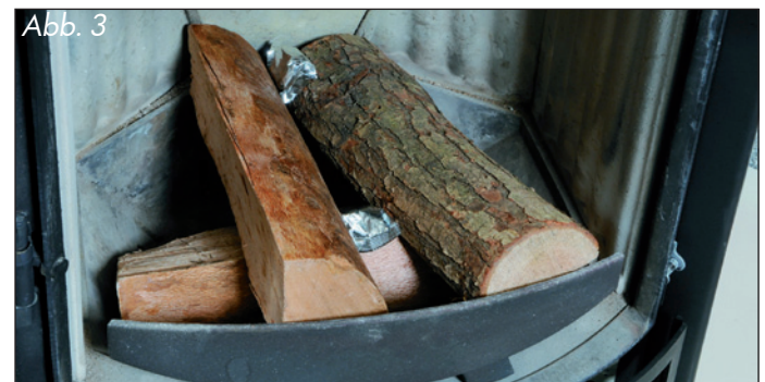
Abb. 3 zeigt Ihnen die Lage der Holzscheite und der Kaminanzünder im Feuerraum der Feuerstätte.
