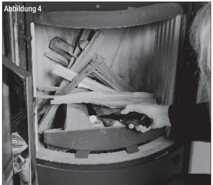
Lassen Sie diese Holzauflage mit geöffneten Verbrennungsluftreglern herunterbrennen, bis eine Grundglut vorhanden ist (Abb. 5).
